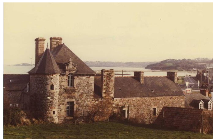
Ensemble nord-ouest, vue générale, réf. AP12R00860, CRMH Bretagne
